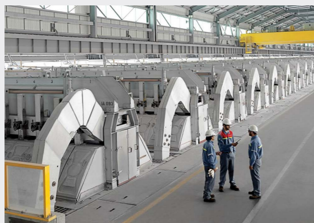
Pohľad do haly s pecami v hliníkárni EGA v meste Al Tawheelah / foto: EGA
